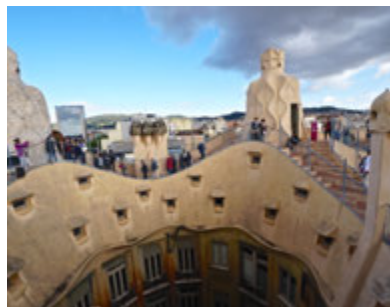
屋上には奇怪な彫刻群が立ち並ぶが、これらのすべてに煙突や換気塔、階段室といった役割がある
