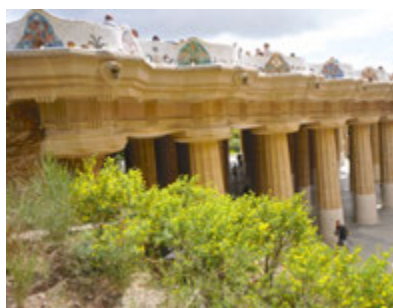
広場の下層部は、屋根付きの市場として計画され、上層部は集会所兼レクリエーション広場として設計された
