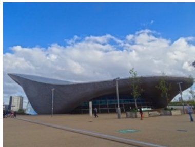
ザハ・ハディドの設計した水泳競技場「アクアティクス・センター」は素晴らしい造形美を誇る大会期間中は巨大な 2 つのウィング（翼）が暫定的に設けられ 17,500 人の収容能力があったが、五輪閉幕後にウィングは撤去されて収容能力は 2,500 人まで縮小され、現在の美しい形状になっている
