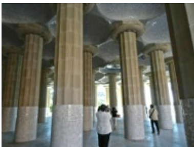
広場空間を支えるドーリア式列柱
