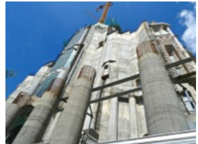
2026年完成を目指し鉄筋コンクリートで建設されているが「神は急がない」と外尾氏は語る
