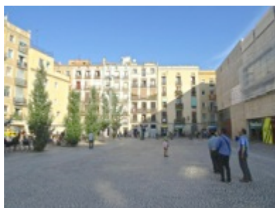
旧市街の治安・衛生面を回復させるため老朽建築を撤去して公共空間と公共施設を建設
