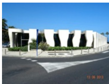
イタリア国境に近いマントンに 2011 年 11 月に開館したジャン・コクトー美術館、設計はマルセイユの Mu CEM のルディ・リッチオッティ。ガラスを多用したフラットな壁面の外側に、屋根から百足や蜘蛛の足のような柱を下ろす構造は、Mu CEM との共通性を感じさせる
