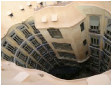
吹き抜けに面する各戸に光があたりやすい
