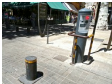
進入許可機付きライジングボラードで車両の進入を制御する
