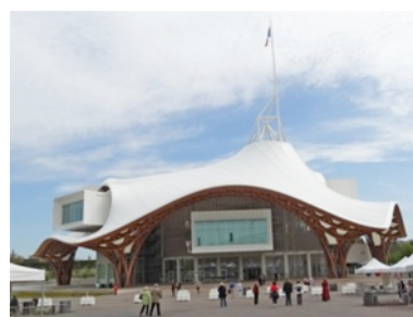
ポンピドゥー・センター・メス全景
