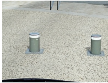
ボルドー旧市街 ライジングボラード (ポールが遠隔制御で上下する)
