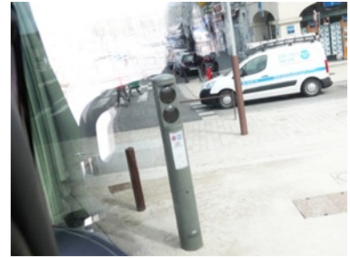
ライジングボラードを制御する機器 (インターホンで係員と通話するタイプもある)
