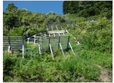
山の斜面には雪崩防止柵が設置
