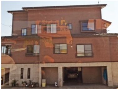
住宅は降雪対策の為、1Fはコンクリート造りの3階建てが多い
