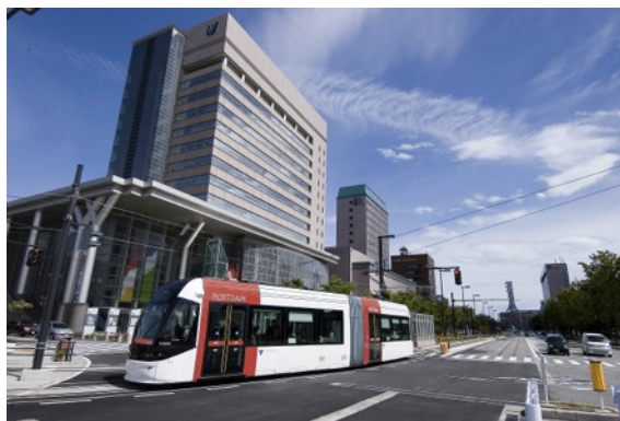
ポータラム・セントラムの走る街 富山市
