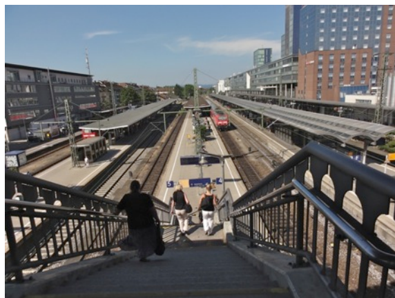
中央駅LRTのホームからドイツ鉄道のホームへ接続。
